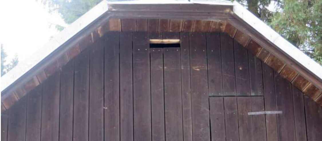
Lesná chata v lokalite Maretkina – vytvorenie nového vletového otvoru do podkrovia pre podkováre malé a iné sprievodné druhy (NP Muránska planina, SK).
